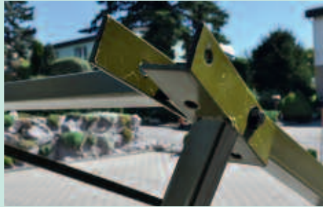
Der Einbau der Verstrebung nach Montageanleitung ist nicht möglich, da hier anscheinend eine Konstruktionsänderung durchgeführt wurde.
